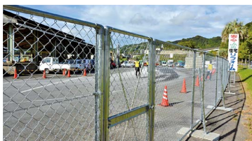
完成した市場内の逃走防止柵
